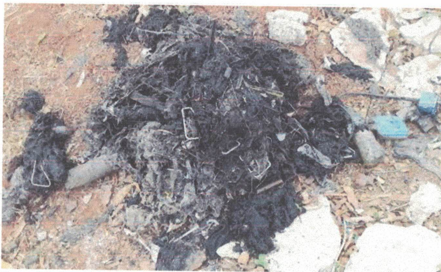
Foto 03: Limpeza PV (ponto de visita rede), ver muitos resíduos de papel, cabelos, plásticos.
