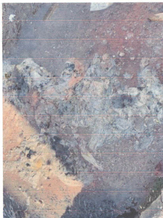
Foto 02: Limpeza caixa coletora de esgoto, ver muitos resíduos de papel, cabelos, plásticos.
